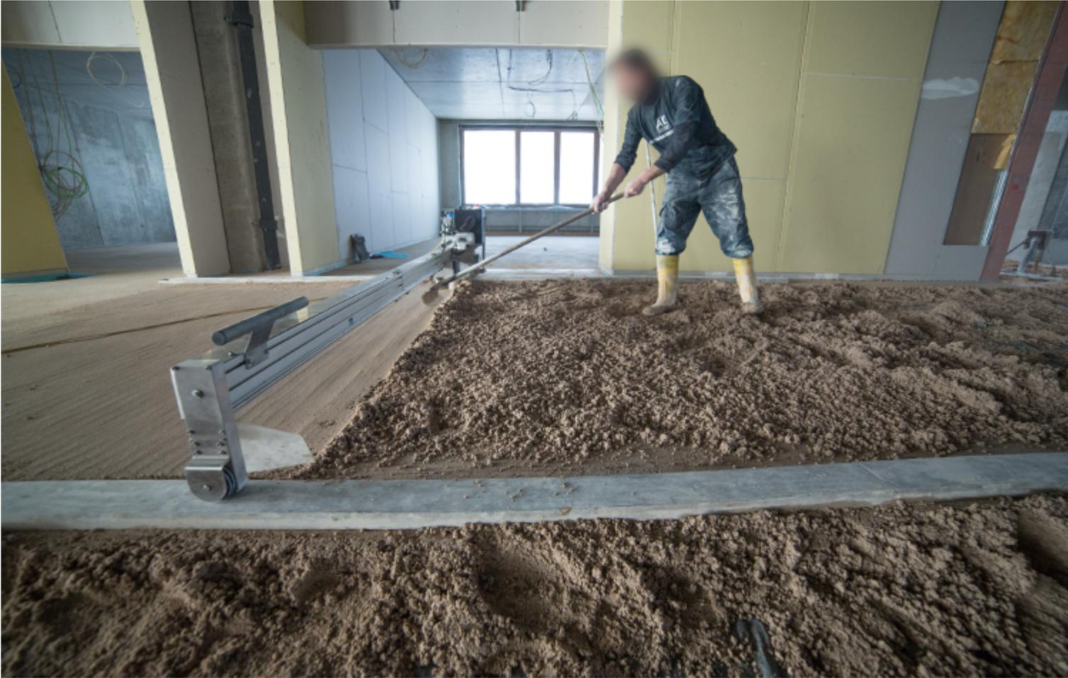
Die Fa. AK Bau GmbH zeigte uns, wie Estrich heutzutage für die optimale Fußbodenkonstruktion erstellt wird.
