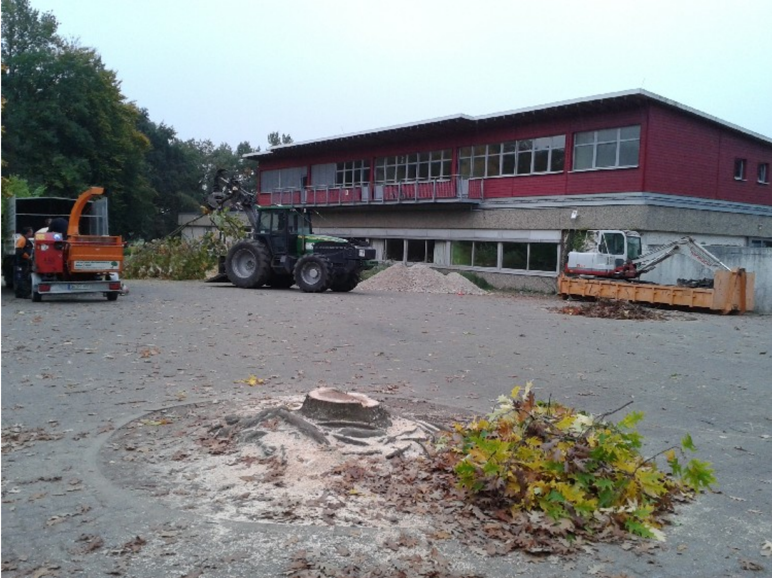
In den nächsten beiden Jahren prägen Baumaschinen die Szene auf dem Schulhof der Hessenwaldschule. Foto Roland Lörzer
