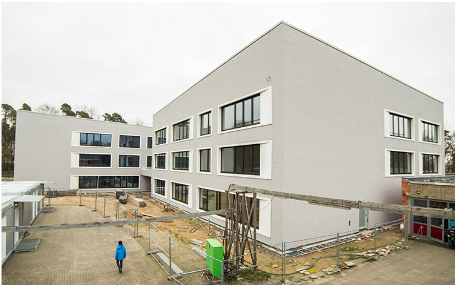
Ab dem 11. April 2016 soll die neue Hessenwaldschule bezugsfertig sein. Dann werden in einem Teil des Altbaus Flüchtlinge untergebracht. Foto Jürgen Henrici
